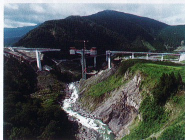
建設半ばの新阿蘇大橋
